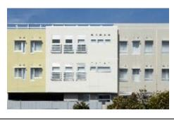
中央の白い部分が2階認知症病棟と3階女性閉鎖 病棟の食堂。近隣への配慮と安全性のため、有孔 折板を取り付け、窓を空けて換気を行うことが出 来るようにしている。
