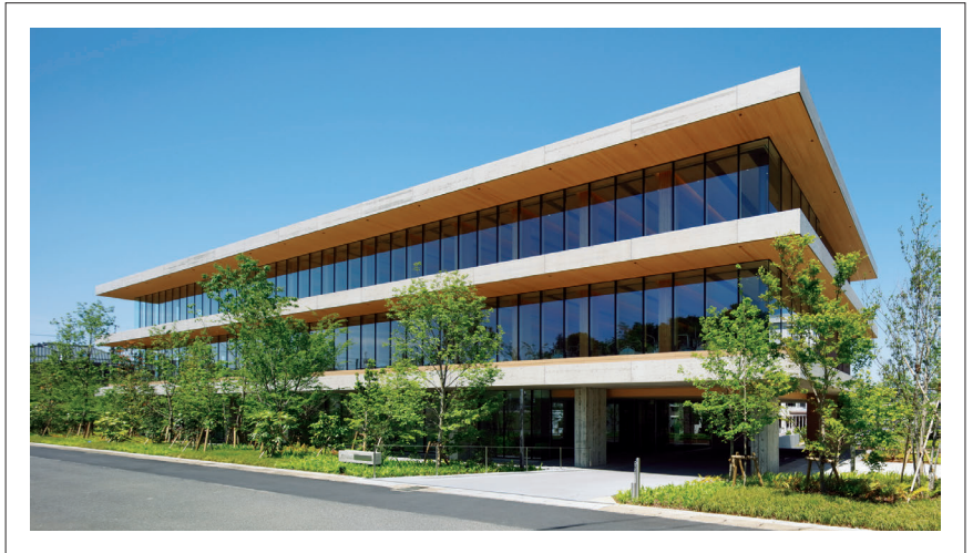
木材を使用した本館
